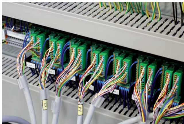
Rozdeľovače Exact12 s ôsmimi konektorovými miestami v lôžku stroja
