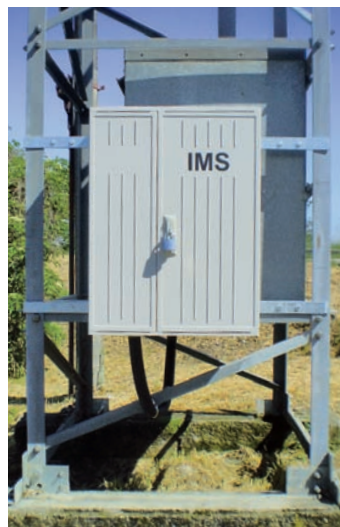
Distribučná transformačná stanica
